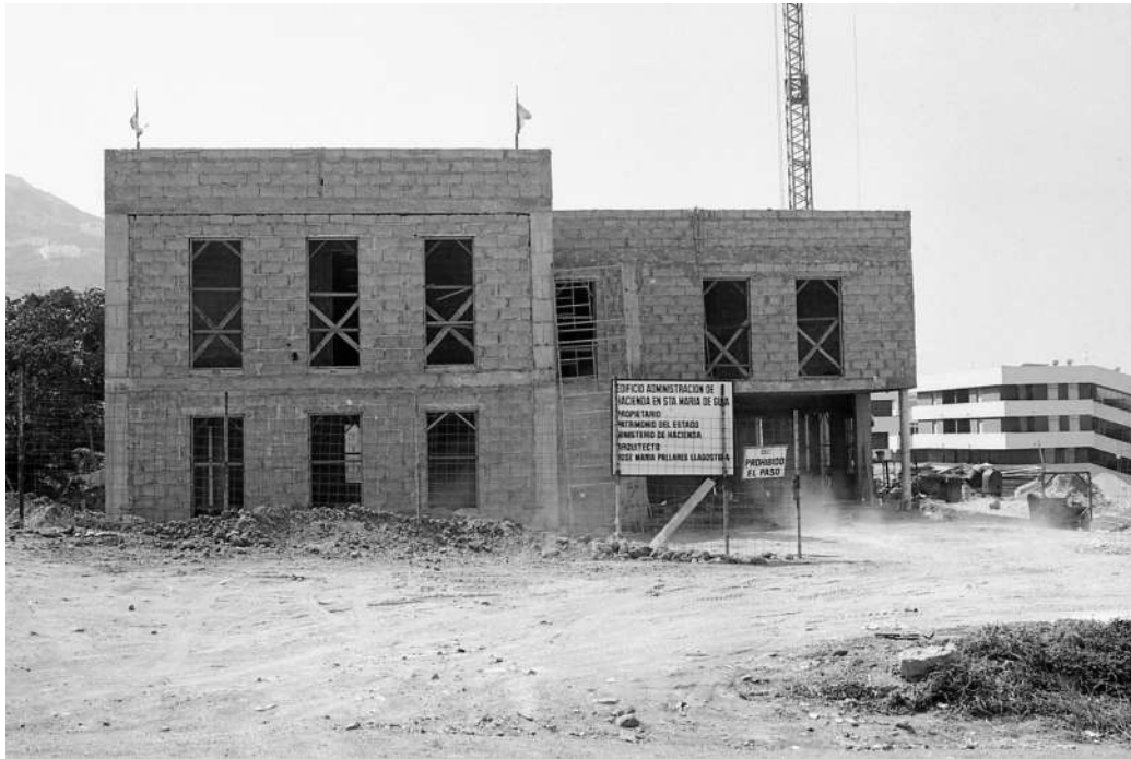
Nuevo edificio de Hacienda en construcción en 1985 (Foto de Paco Rivero-Fundación Canaria Néstor Álamo)
