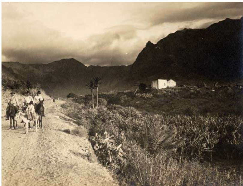
ARRIEROS Y CARRETERA EN EJECUCIÓN A LA ALTURA DEL «ROQUE DE CHAPÍN» A LA CRUZ CHIQUITA, 1923-1926. FOTOGRAFÍA DE TEODORO MAISCH. BVPB-MECD
