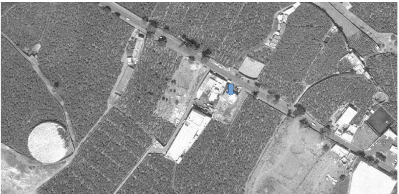
Foto aérea de 1977. La flecha indica el lugar donde ya está construida la Casa del Médico en el Lomo de Guillén (Grafcan)
