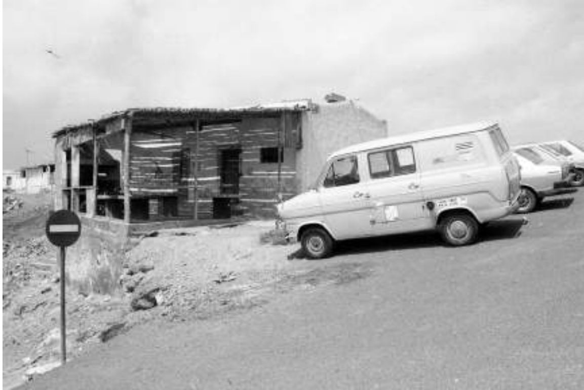
Bar construido por el Ayuntamiento en 1978 (Foto de Paco Rivero-FCNA)
