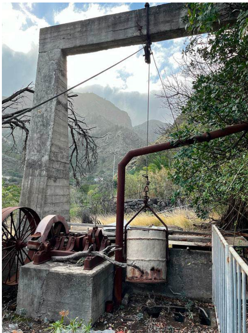
Brocal del pozo y los demás elementos [MJSS]
