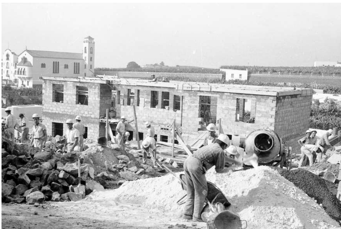
Construcción de las viviendas en 1965 (Foto de Paco Rivero-Fundación Canaria Néstor Álamo)
