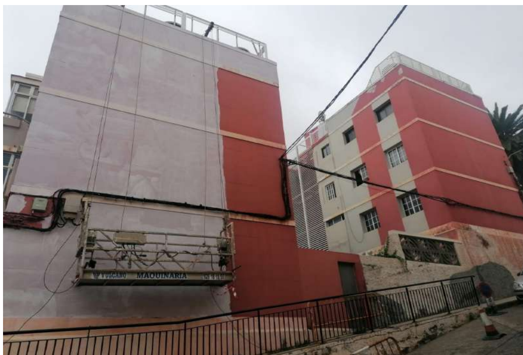
Edificios en la zona del juzgado (julio 2026-Foto de Sergio Aguiar)
