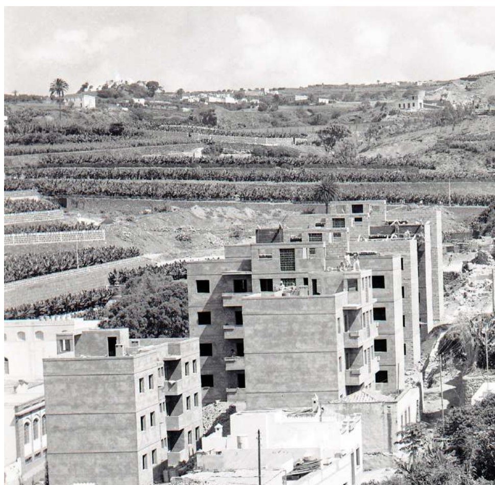
Las viviendas en la zona baja de la calle Real en construcción en 1966 (Foto de Paco Rivero-Fundación Canaria Néstor Álamo)
