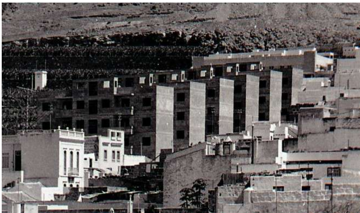
Las viviendas en la zona de San Roque en construcción en 1966 (Foto de Paco Rivero-Fundación Canaria Néstor Álamo)
