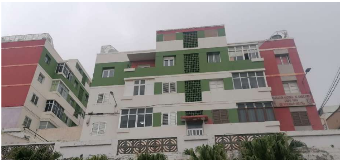
“Grupo Tirma” en la actualidad julio de 2026 que están siendo rehabilitadas (Foto de Sergio Aguiar)
