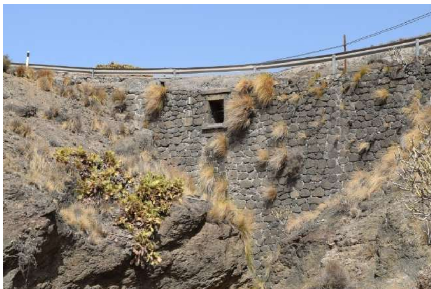
EL LLAMADO «PUENTE ALTO», OBRA DE INGENIERÍA DE JUAN DE LEÓN Y CASTILLO, DE LA SEGUNDA MITAD DEL SIGLO XIX. EN REALIDAD MÁS QUE UN PUENTE ES UNA TAJEA, DISEÑADO PARA DESAGUAR EL CAUCE DE UN BARRANQUILLO. FOTOGRAFÍA DE ANTONIO J. CRUZ Y SAAVEDRA, 2020
