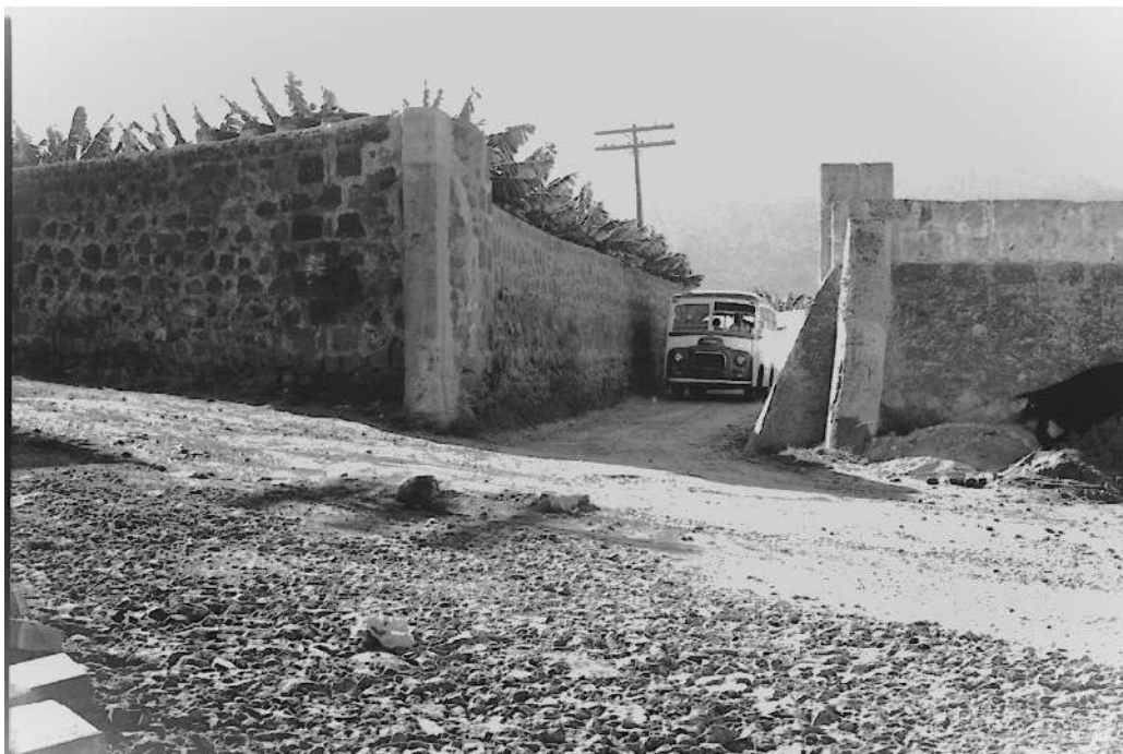
A la derecha de la foto el estanque donde se construirá el Mercado Municipal (Foto Elías Gil)
