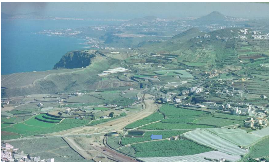
El estanque con las obras de la autovía del norte de Gran Canaria (FEDAC)
