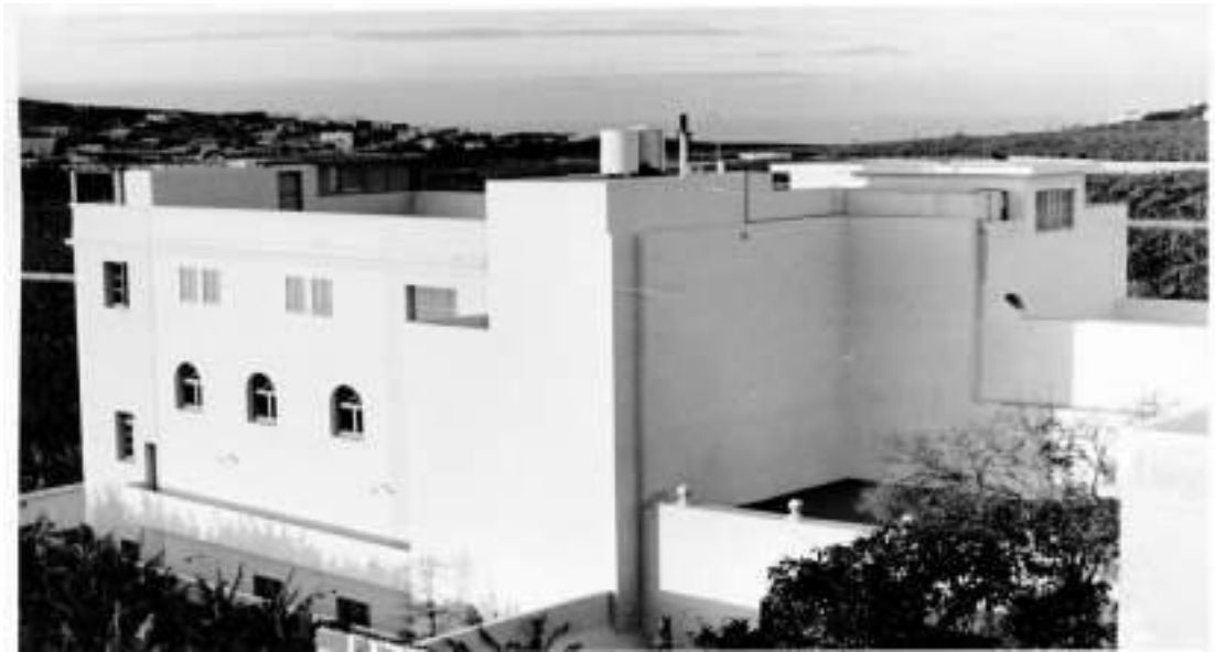
Nuevo edificio de las Dominicas construido en los primeros años de la década de los 50 del siglo XX (Archivo fotográfico de Juan García Mateos)
