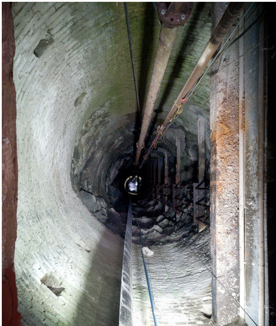
Pozo canario forrado en sus primeros metros [JG]
