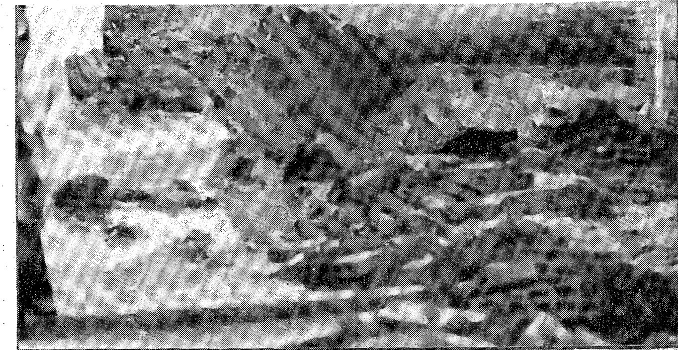
Aquí estaba el embalse que reventó, cuya construcción era bastante antigua
